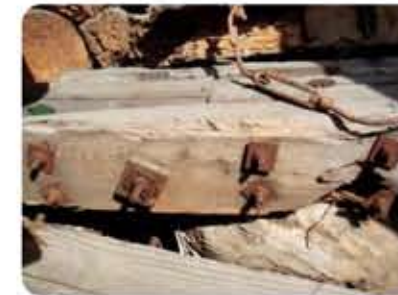
ボルト等の異物が付着している解体廃材
