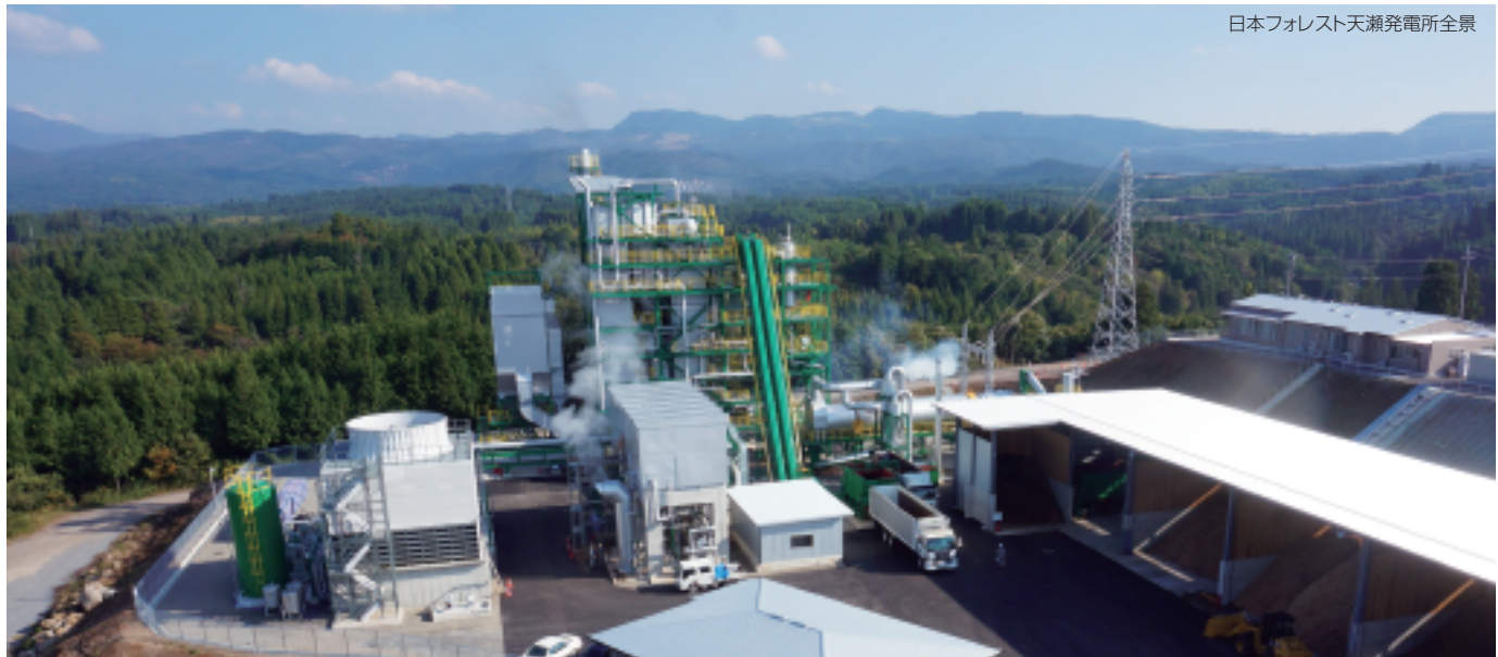
日本フォレスト天瀬発電所全景
